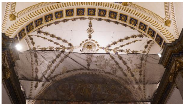
Figura 13. Estado Inicial de Intradós de bóveda de Capilla de Dolores.
