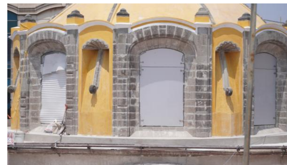
Figura 9. Después de los trabajos en extradós de Cúpula Principal.
