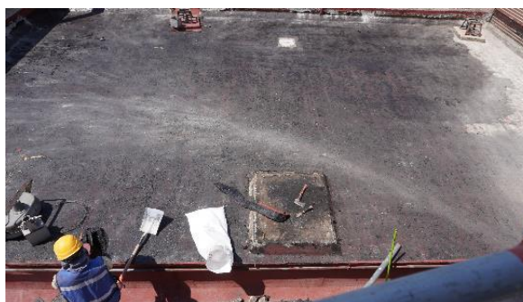
Figura 17. Durante los trabajos en cubiertas.
