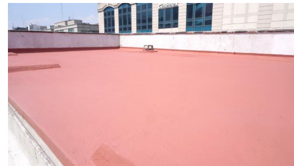
Figura 18. Estado Final en cubiertas.
