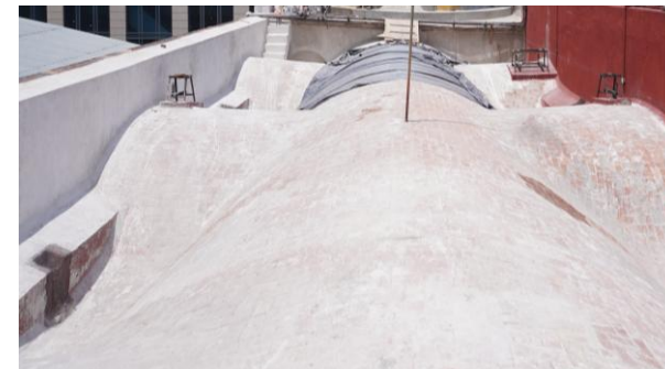
Figura 3. Estado Final en extradós de bóveda de Nave Principal.
