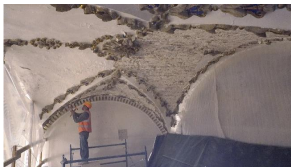
Figura 14. Durante los trabajos del Intradós de bóveda de Capilla de Dolores..
