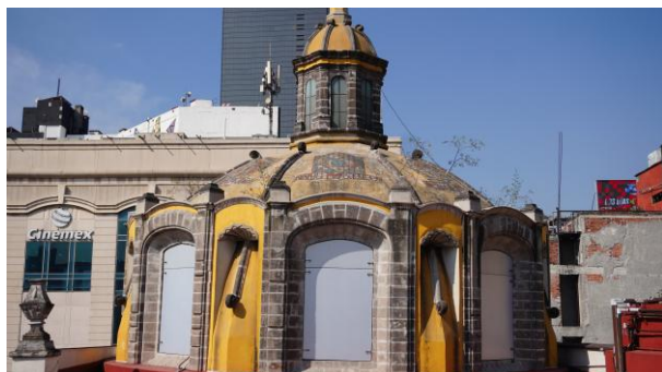
Figura 7. Estado Inicial de extradós de Cúpula Principal.
