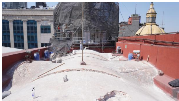
Figura 2. Durante los trabajos en extradós de bóveda de Nave Principal.
