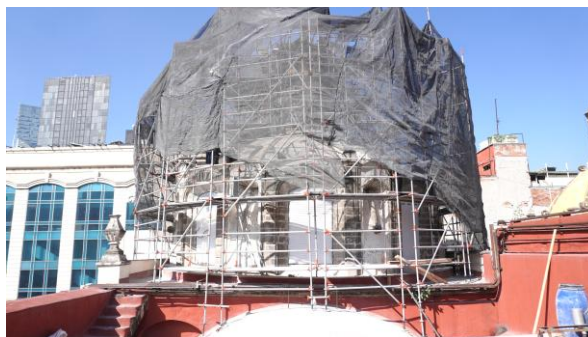
Figura 8. Durante los trabajos en extradós de Cúpula Principal.
