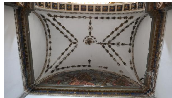
Figura 15. Después de los trabajos en Intradós de bóveda de Capilla de Dolores.
