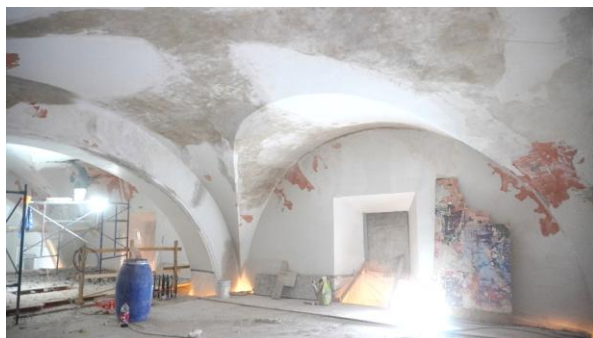
Figura 5. Durante los trabajos en intradós de bóvedas de Nave Principal.
