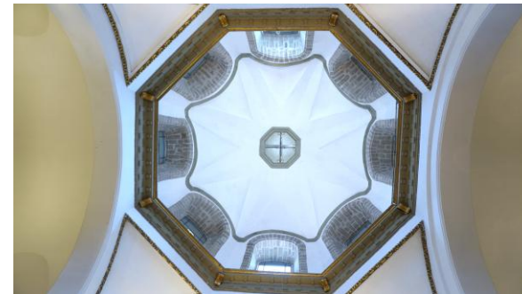
Figura 12. Después de los trabajos en intradós Cúpula Principal.
